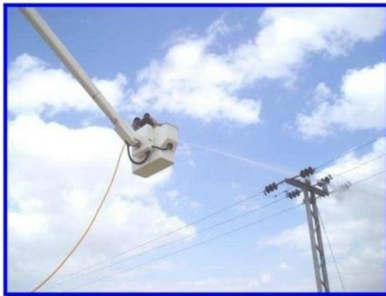
Plataforma para dos operarios y brazo articulado totalmente aislados para un lavado seguro en alturas de hasta 22m y en líneas energizadas de hasta 500kV con el sistema comprobado de lavado de aisladores de Translink.
